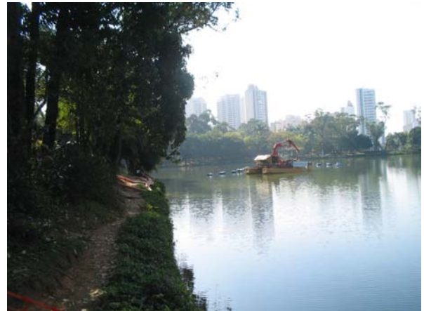
Foto 58 (julho/2010): Máquina instalada para as obras de limpeza do lago do Parque da Aclimação; a ideia é retirar 4.700 toneladas de lodo úmido.
