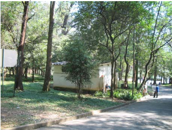
Foto 17 (julho/2010): Edificação no Parque da Aclimação (banheiro)
