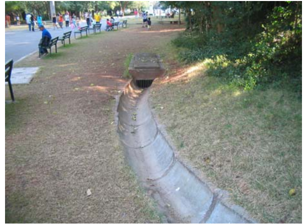
Foto 44 (julho/2010): Sistema de drenagem implantado na nova área de paisagismo
