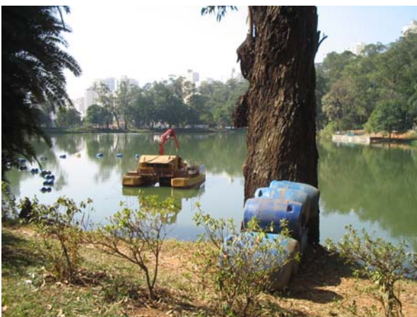
Foto 59 (julho/2010): A retirada do lodo do lago é feita por sucção em baixa velocidade, a partir de uma máquina instalada numa balsa flutuante que percorrerá o lago em toda a sua extensão.
