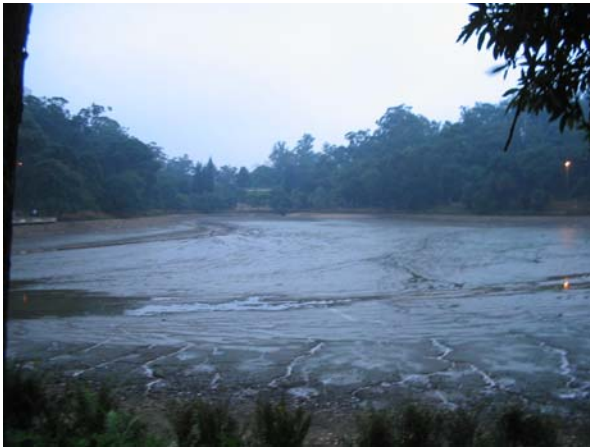
Foto 55 (fevereiro/2009): Lago do Parque da Aclimação seco, devido ao rompimento do vertedouro ocorrido após um grande temporal, em fevereiro de 2009.
