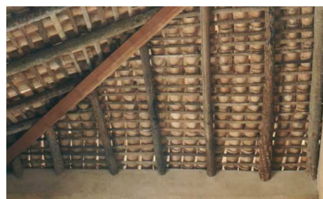
Figura 4 - Vista de uma cobertura com mastros do caule da carnuabeira.
