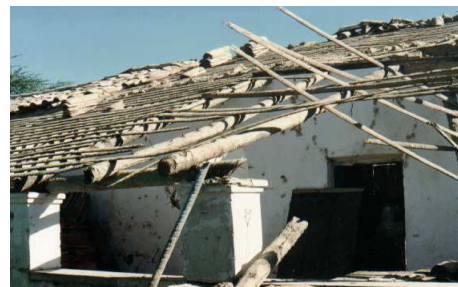
Figura 3- Estrutura de madeira da carnaubeira sob telhas de barro tipo capa e canal com e estrutura adicional de tronco de carnaúba (Foto de Ricardo Carranza, 2000)
