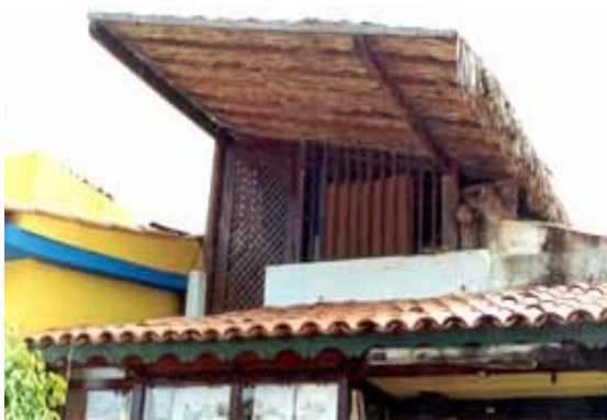
Figura 2- Cobertura de uma edificação com folhas de carnaúba, ventilação permanente
