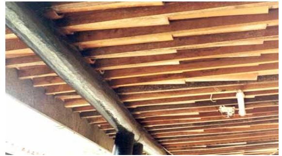
Figura 3- Estrutura de madeira da carnaubeira sob telhas de barro tipo capa e canal com e estrutura adicional de tronco de carnaúba (Foto de Ricardo Carranza, 2000)
